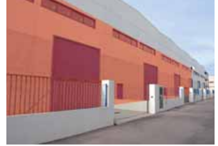
Protection de murs extérieur d'entrepôt
